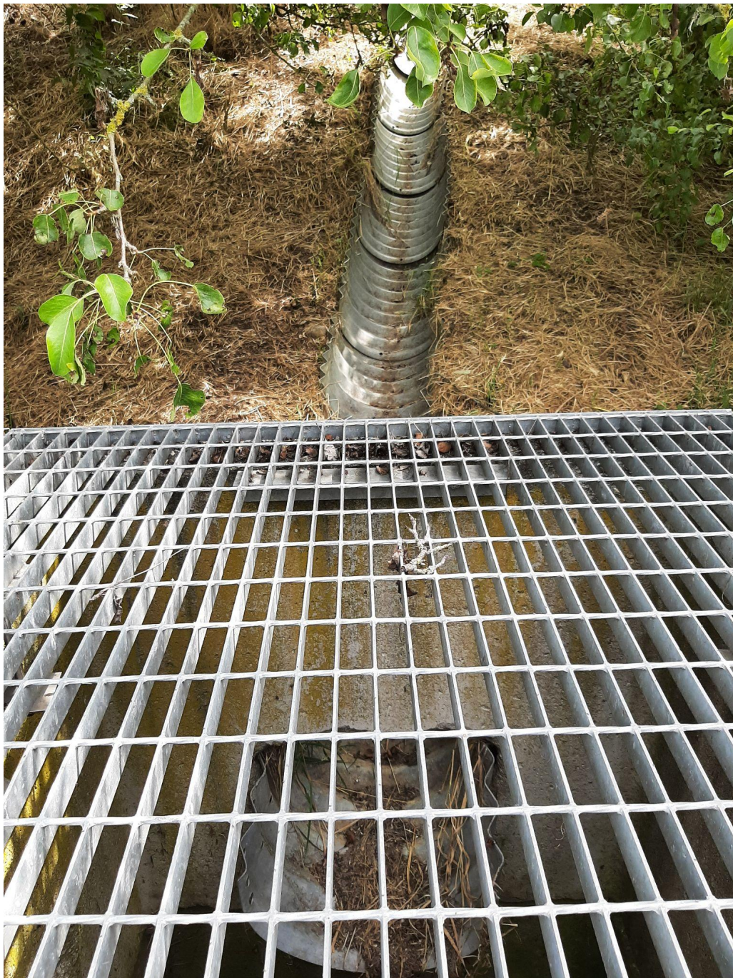
Foto 3 – calate in lamiera zincata che convogliano le acque meteoriche di ruscellamento dal corpo di scarica
