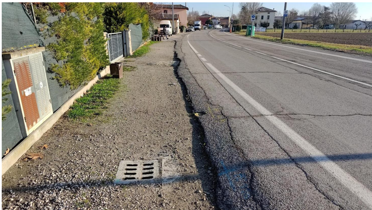
Figura 1 – SP5 – area di inizio intervento lato ovest con allargamento sede stradale e realizzazione di semaforo ciclabile a chiamata
