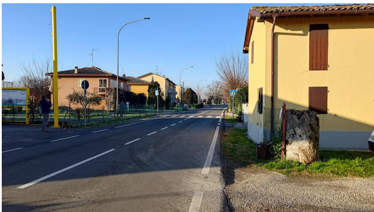
Figura 6 – Mondonuovo (prolungamento (80 m) di percorso ciclabile esistente sul lato sinistro
