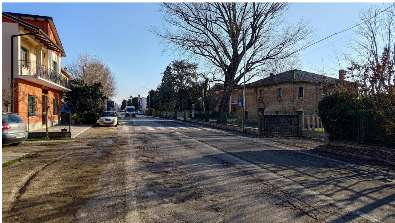
Figura 3 - SP5 – tratto di realizzazione di piste ciclabili su corsia riservata tramite allargamento della banchina stradale
