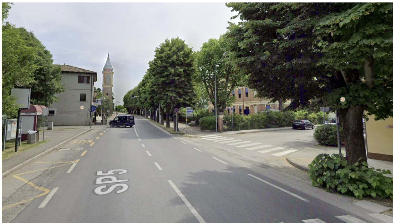
Figura 5 – SP5 intersezione via Unità d'Italia – termine tratto di realizzazione pista ciclopedonale in sede propria e risanamento percorso pedonale pressi scuola elementare
